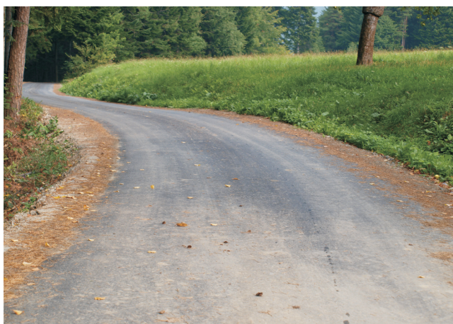
Droga gminna „Pod przekażnik” w Podłopieniu
